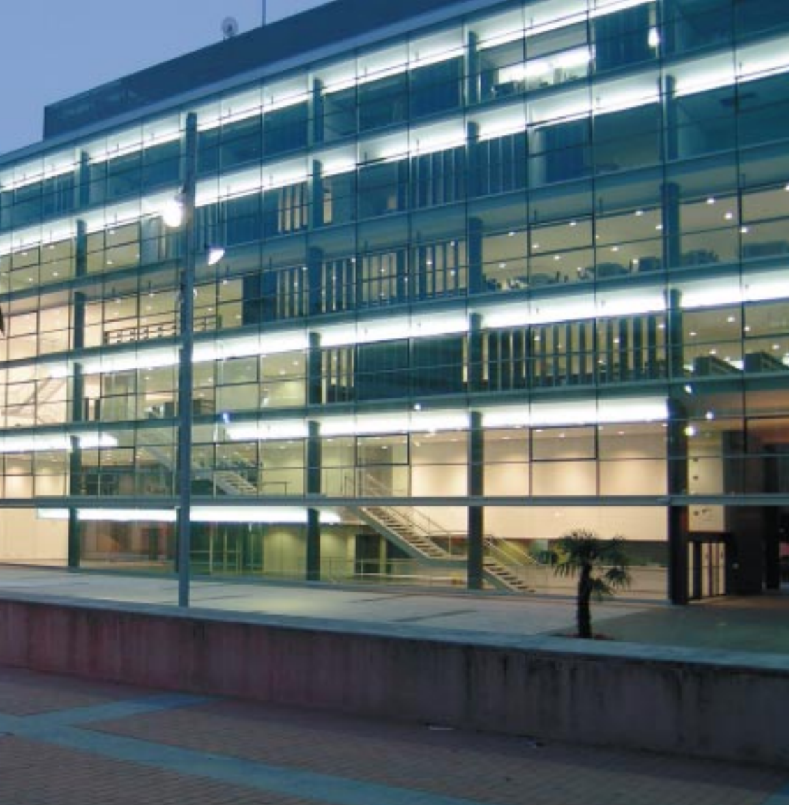
Entrada principal al nuevo y completo equipamiento cultural. Kultur ekipamendu berri eta osoturako sarrera nagusia.
